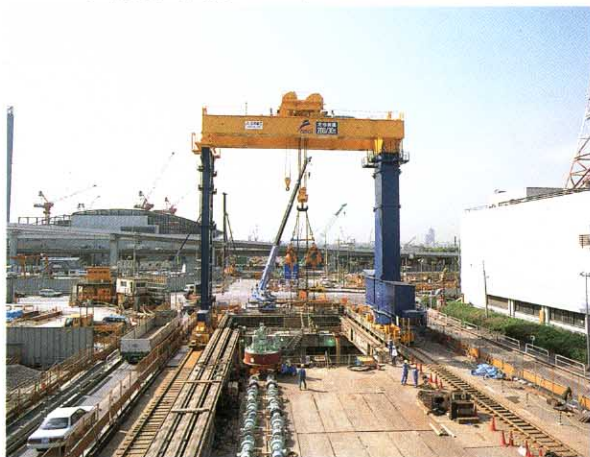
シールド機投入状況 Lifting down the shield machine
