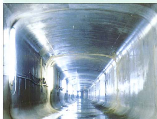
二次覆工完成状況 Inside of the secondary lining
