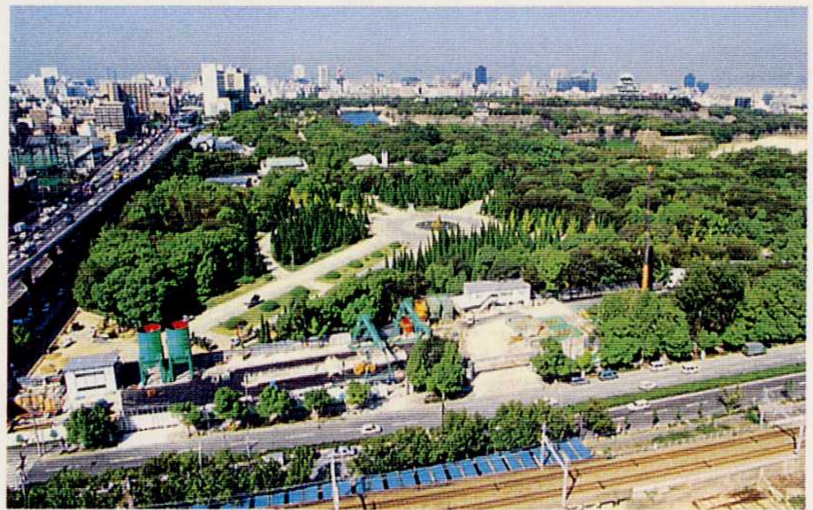
発進基地付近全景
